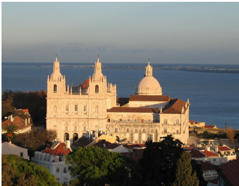
FIG. 101 Mosteiro de São Vicente de Fora, Lisboa, fachada principal e cobertura. https://commons.wikimedia.org/wiki/File:Sao_Vicente_de_Fora.jpg
