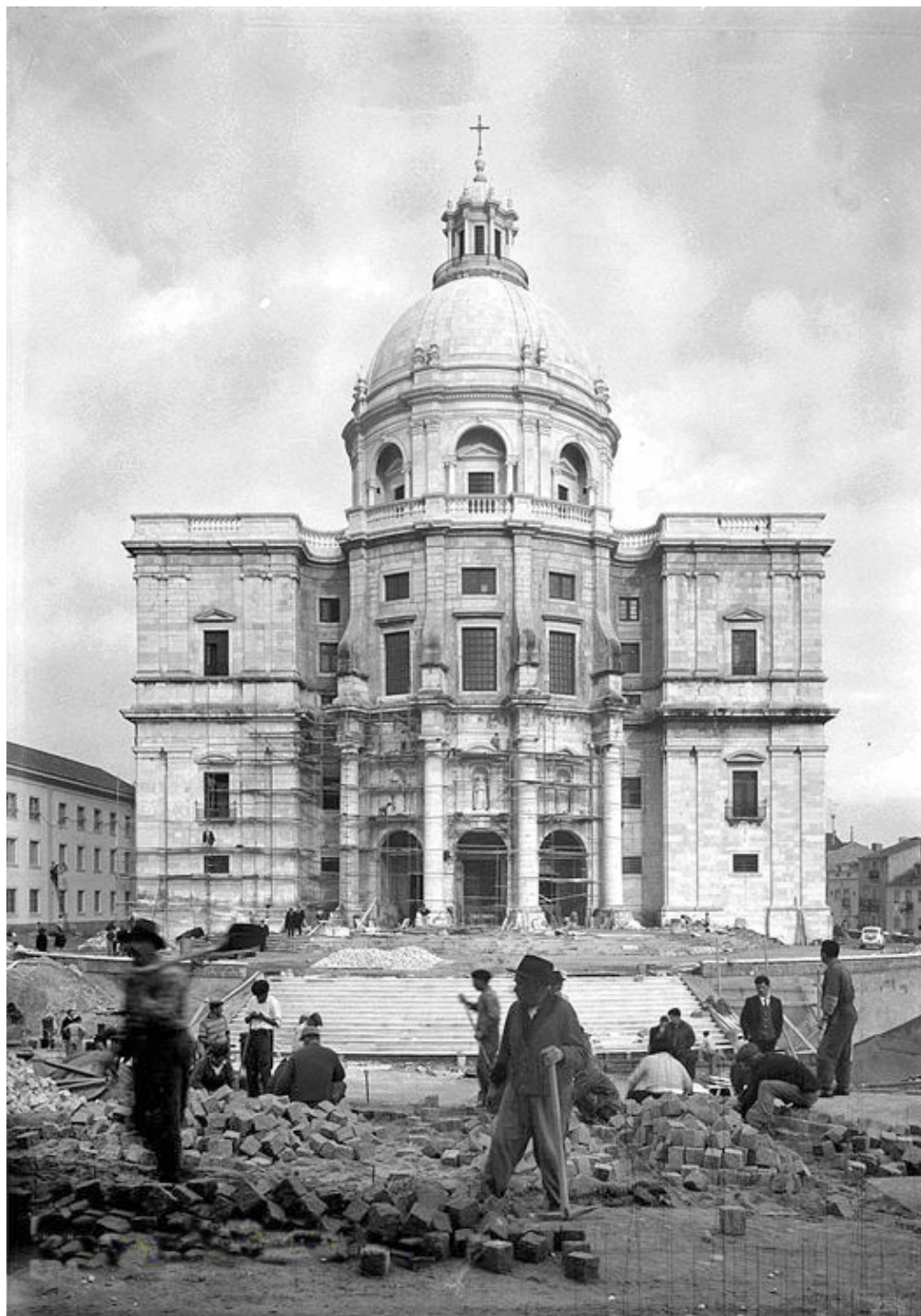
FIG. 148 Obras de Santa Engrácia, 21 de Novembro de 1966, Arquivo da DGEMN.
