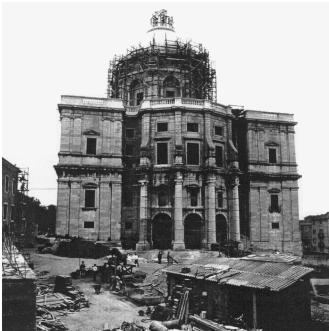
FIG. 146 Obras de Santa Engrácia, 10 de Agosto de 1966, Arquivo da DGEMN.
