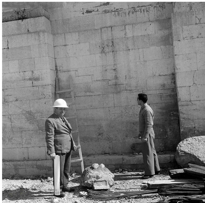
FIG. 153 Igreja de Santa Engrácia / Panteão Nacional, estaleiro de obras, execução de um molde de um capitel, 30 de Julho de 1965, Arquivo da DGEMN.
