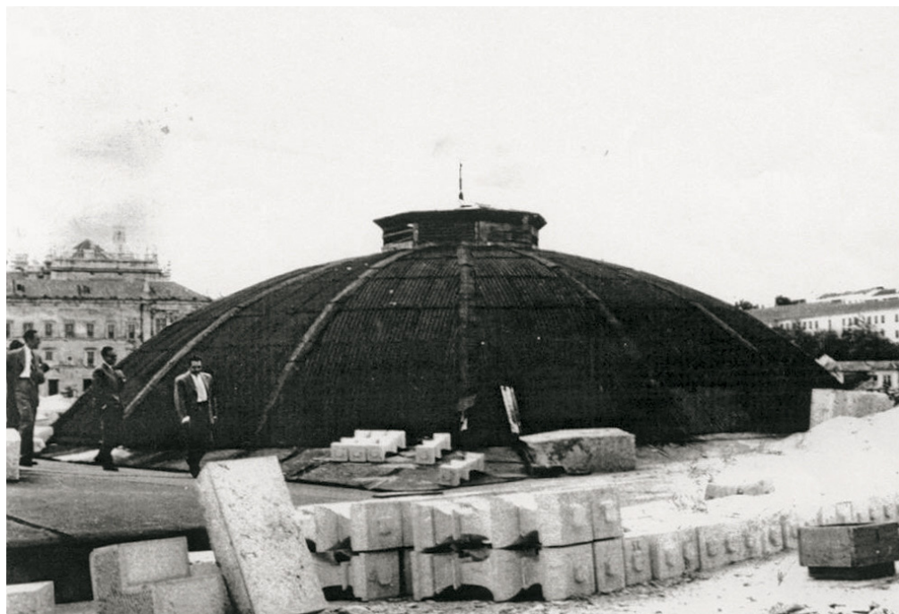
FIG. 134 Cúpula de zinco colocada pelo exército no século XIX, s.d., Arquivo da DGEMN.
