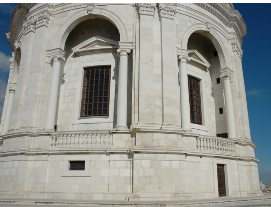
FIG. 201 Igreja de Santa Engrácia / Panteão Nacional, janela, pilastras e colunas exteriores da cúpula, fotografia SM.
