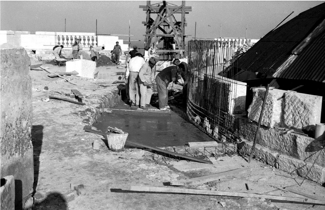
FIG. 117 As obras de Santa Engrácia, cúpula e terraço, 14 de Novembro de 1962, Arquivo da DGEMN.
