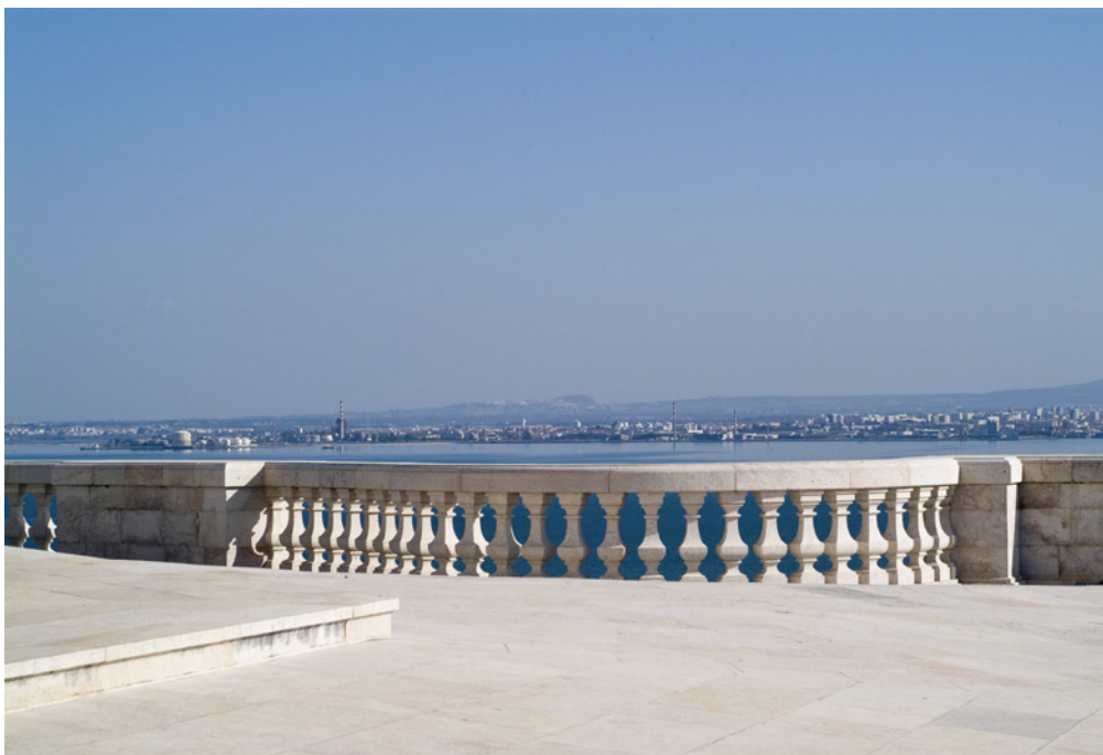
FIG. 207 Igreja de Santa Engrácia / Panteão Nacional, terraço e balaustrada, ao fundo o Tejo, fotografia SM.
