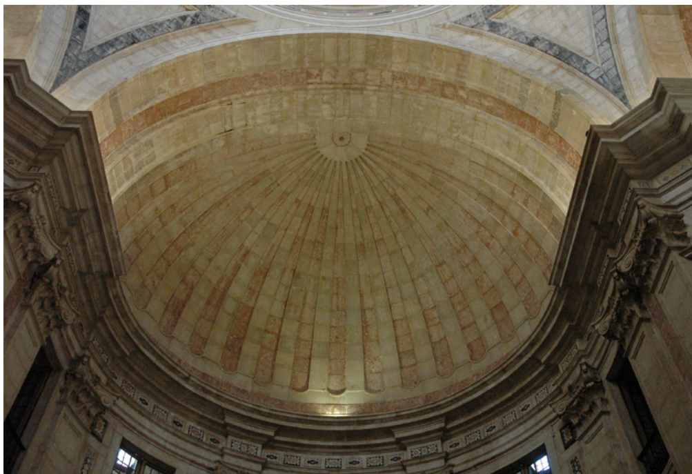
FIG. 223 Igreja de Santa Engrácia / Panteão Nacional, interior, cobertura de um dos braços da igreja, fotografia SM.
