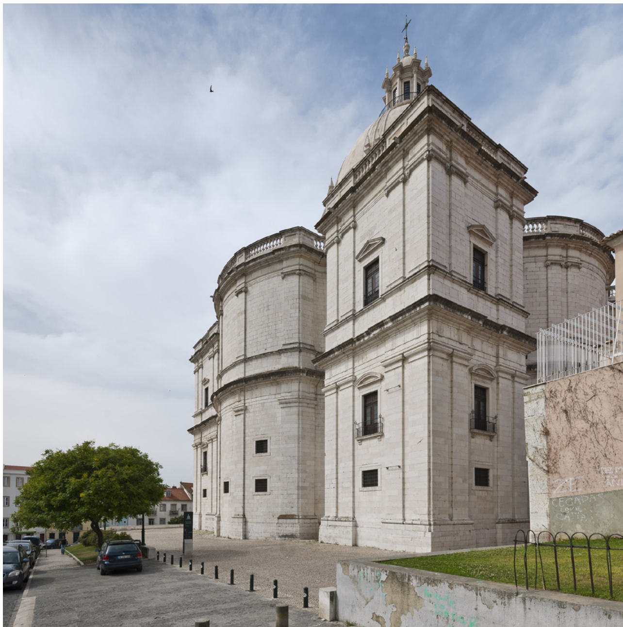
FIG. 159 Igreja de Santa Engrácia / Panteão Nacional, fachada posterior (Nascente), fotografia José Paulo Ruas (2011), Museus e Monumentos de Portugal E.P.E. / Arquivo de Documentação Fotográfica, 51528 DIG.
