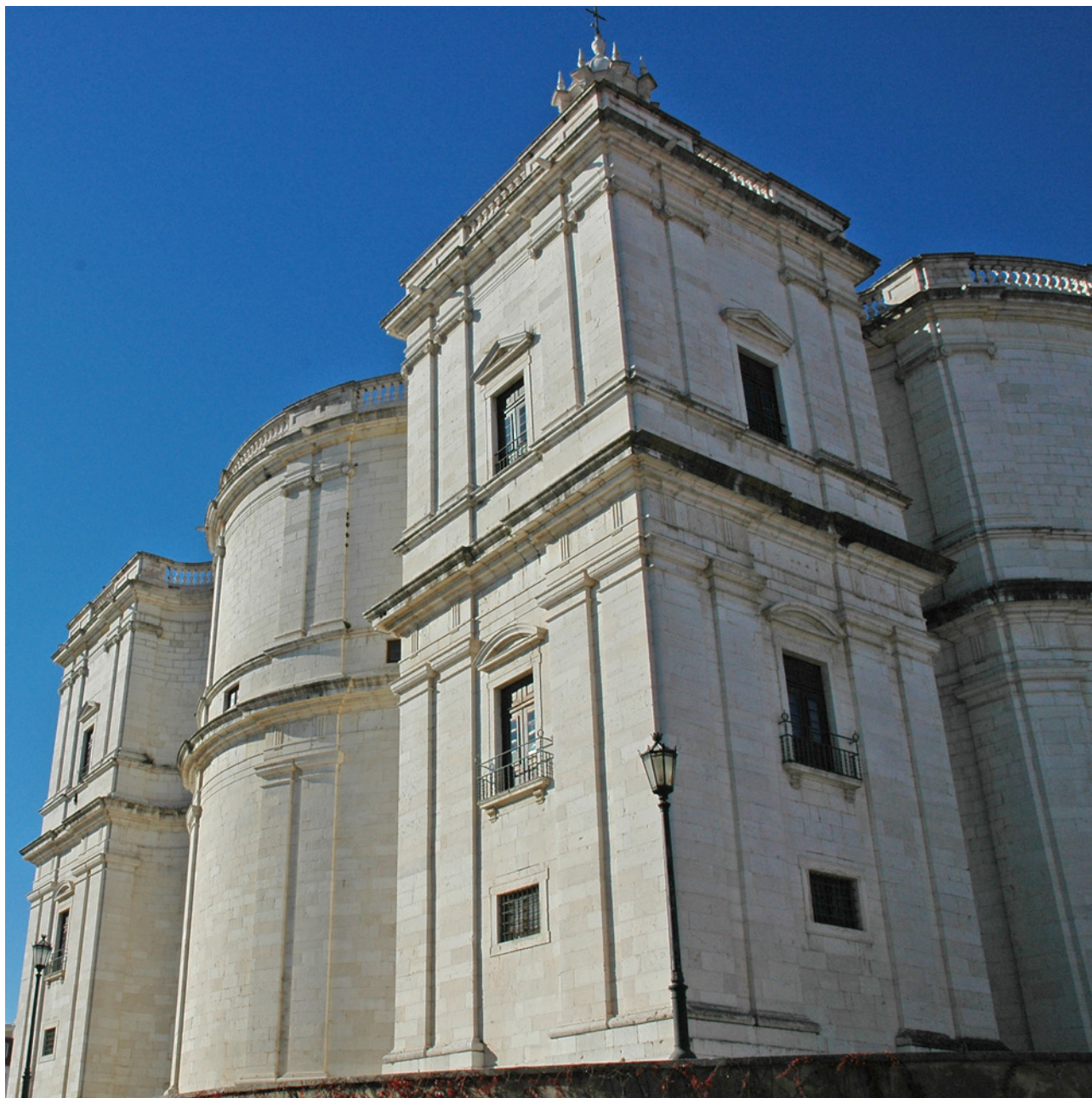
FIG. 160 Igreja de Santa Engrácia / Panteão Nacional, fachada lateral (Sul), fotografia SM.
