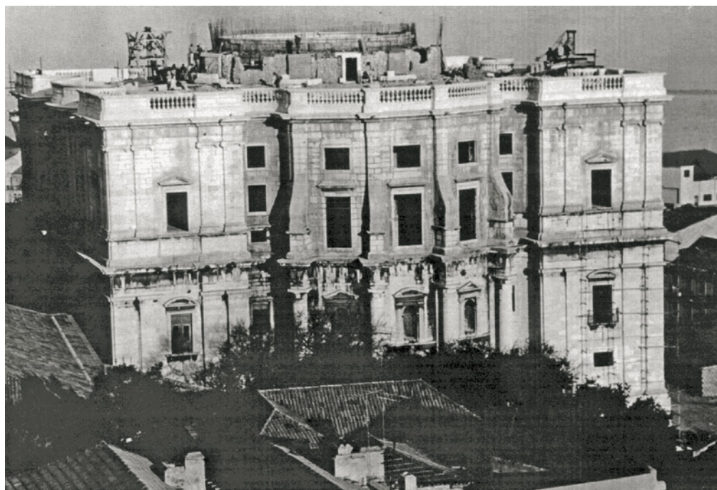
FIG. 135 Obras de Santa Engrácia, 17 de Novembro de 1964, Arquivo da DGEMN.
