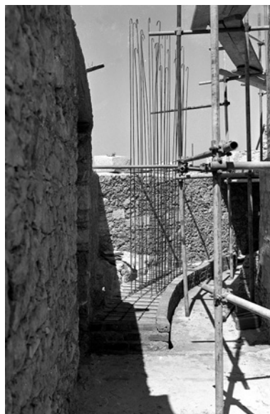
FIGURA 3.5 Construção do anel de betão armado. Esquerda: arranque do pilar de suporte do corpo cilíndrico exterior à cota +25,00 m. Direita: pormenor da parede de betão armado e alvenaria de tijolo do corpo cilíndrico inferior e parede de betão ciclópico do corpo cilíndrico exterior.
