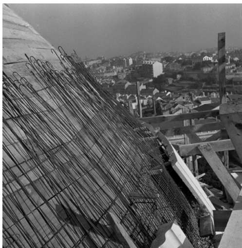
FIGURA 3.11 Construção das cúpulas: Esquerda: armadura e aplicação da pedra de revestimento que serve de cofragem, para a cúpula exterior. Direita: transição da cúpula exterior para o lanternim.
