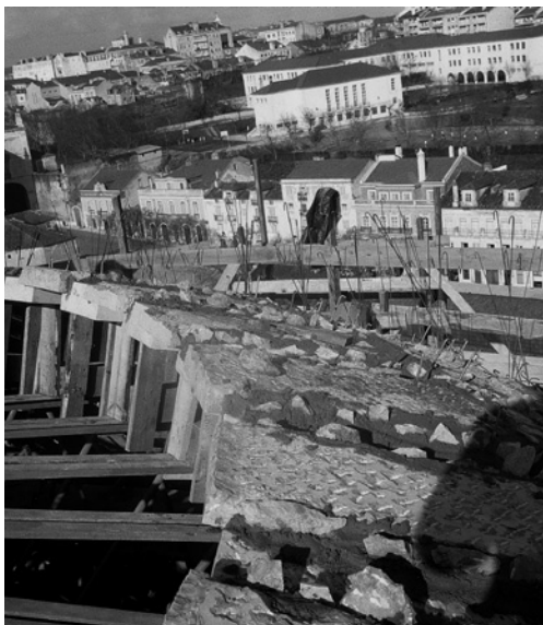
FIGURA 3.12 Construção das cúpulas. Esquerda: pormenor dos elementos metálicos inseridos na pedra de revestimento da cúpula interior que conferem juntamente com as argamassas a ligação com o betão armado. Direita: zona de fecho da cúpula exterior e início da construção do lanternim. SIPA.FOTO.00507445 (esquerda) / Delgado, J., 2006 (direita).
