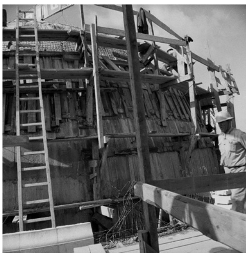
FIGURA 3.9 Construção das cúpulas. Esquerda: arranque das armaduras na cúpula interior. Direita: faseamento da cofragem para a betonagem, cúpula interior.
