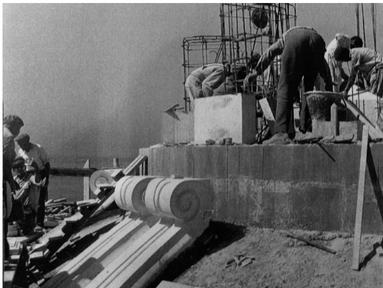
FIGURA 3.12 Construção das cúpulas. Esquerda: pormenor dos elementos metálicos inseridos na pedra de revestimento da cúpula interior que conferem juntamente com as argamassas a ligação com o betão armado. Direita: zona de fecho da cúpula exterior e início da construção do lanternim. SIPA.FOTO.00507445 (esquerda) / Delgado, J., 2006 (direita).
