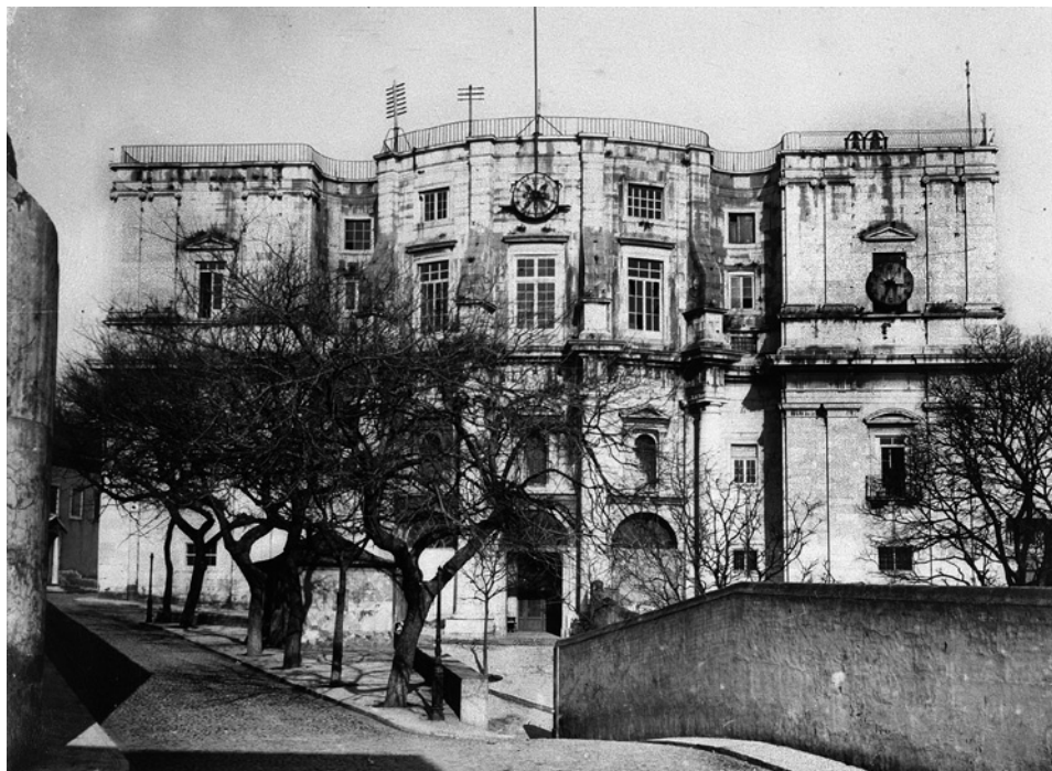
FIGURA 3.16 Fachada principal. Cima: antes das obras, 1960. Baixo: depois das obras.
