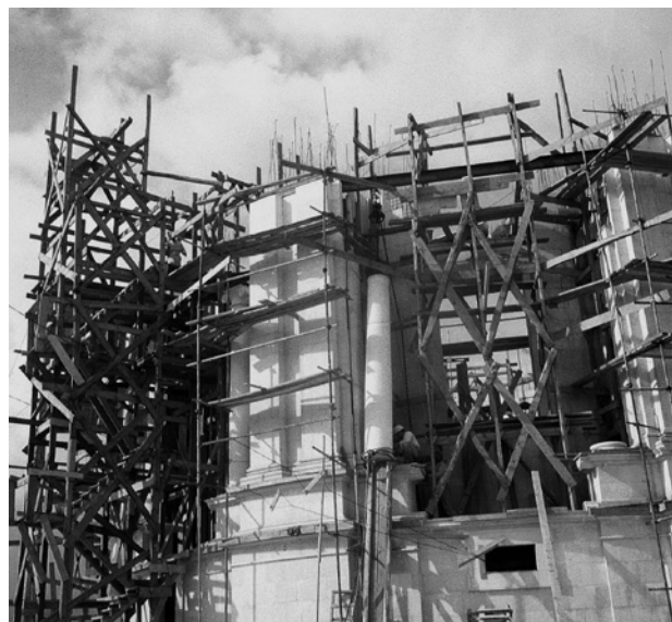
FIGURA 3.7 Construção do tambor. Esquerda: pormenor do sistema de construção do corpo cilíndrico interior, ao nível dos janelões. Direita: vista pelo exterior da construção do tambor.
