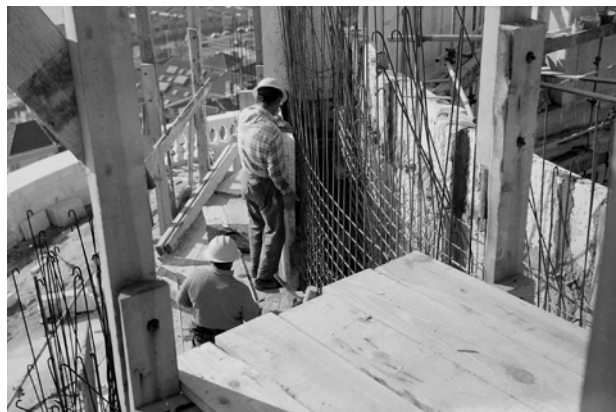
FIGURA 3.6 Construção do tambor. Cima: tambor exterior ao nível do terraço. Baixo: tambor interior da cúpula num nível superior ao terraço. SIPA.FOTO.00505962 / SIPA.FOTO.00505995
