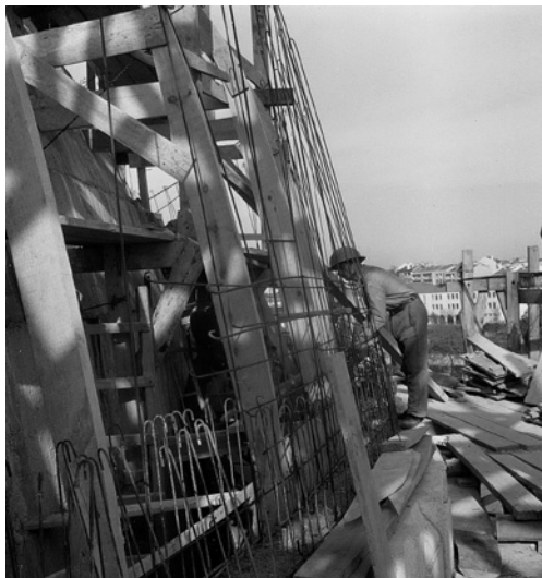
FIGURA 3.10 Construção das cúpulas: preparação da cofragem da cúpula exterior.
