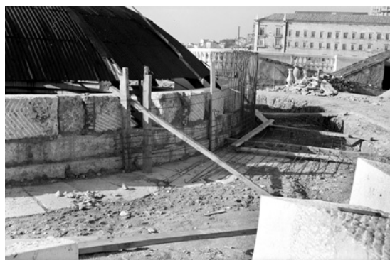
FIGURA 3.4 Início da construção do anel de betão armado: laje de betão armado à cota 25 m.
